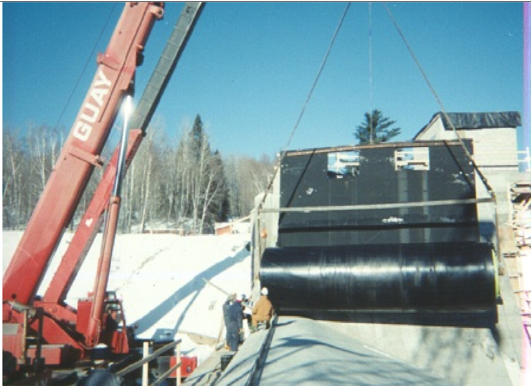
Déroulement du barrage en caoutchouc sur le barrage principal, 1999
