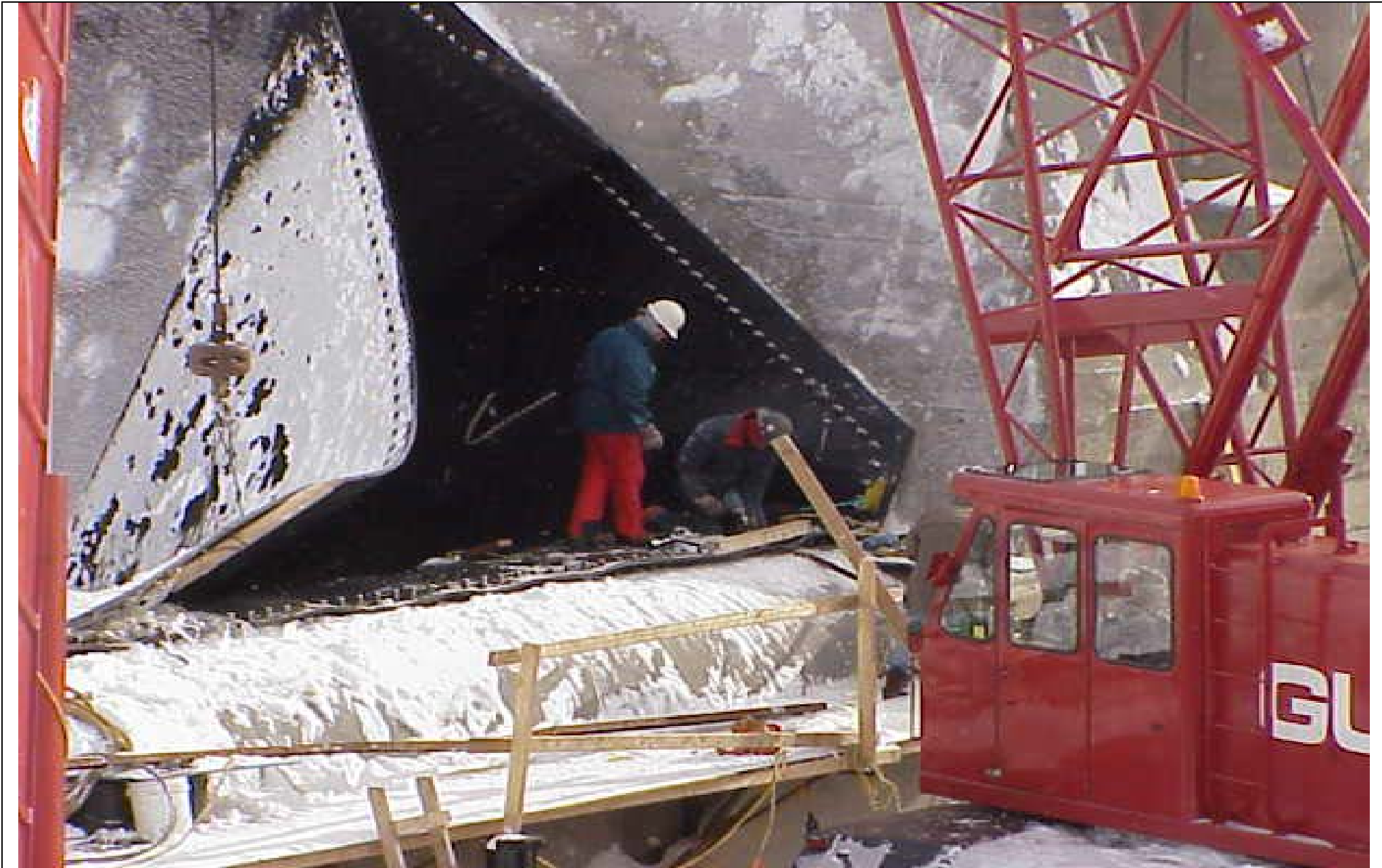
Ajustement final du barrage en caoutchouc à l'extrémité sud du barrage principal, 1996 6
