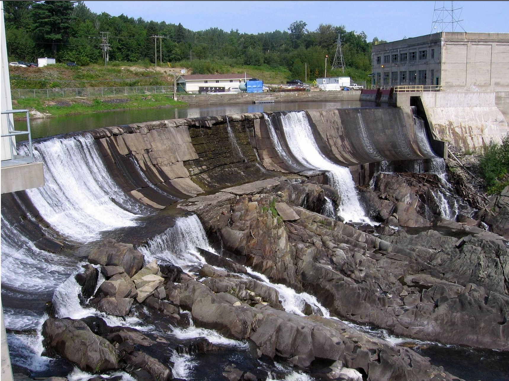
Vue du barrage déversant du bassin d'admission
