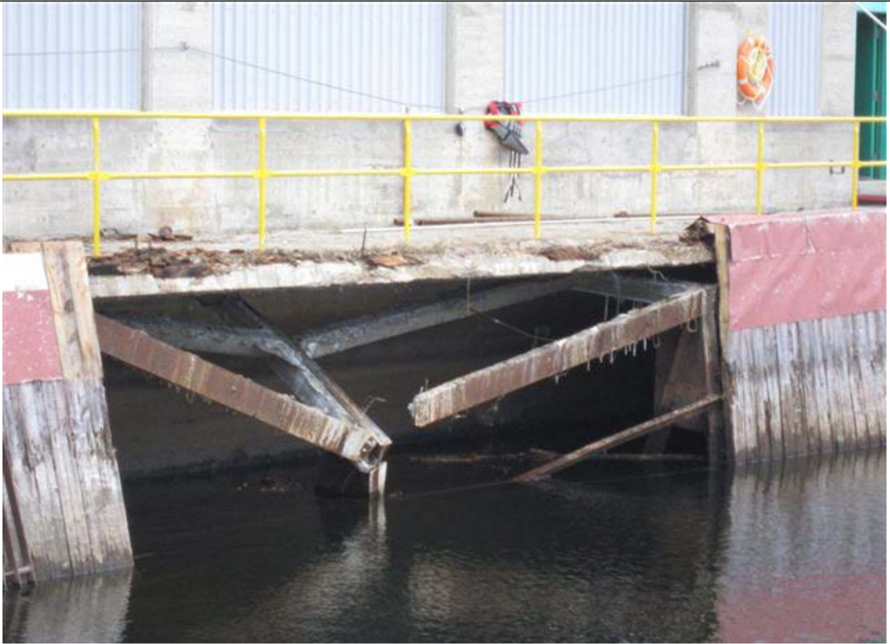
Vue des pièges à débris endommagés Décembre 2010
