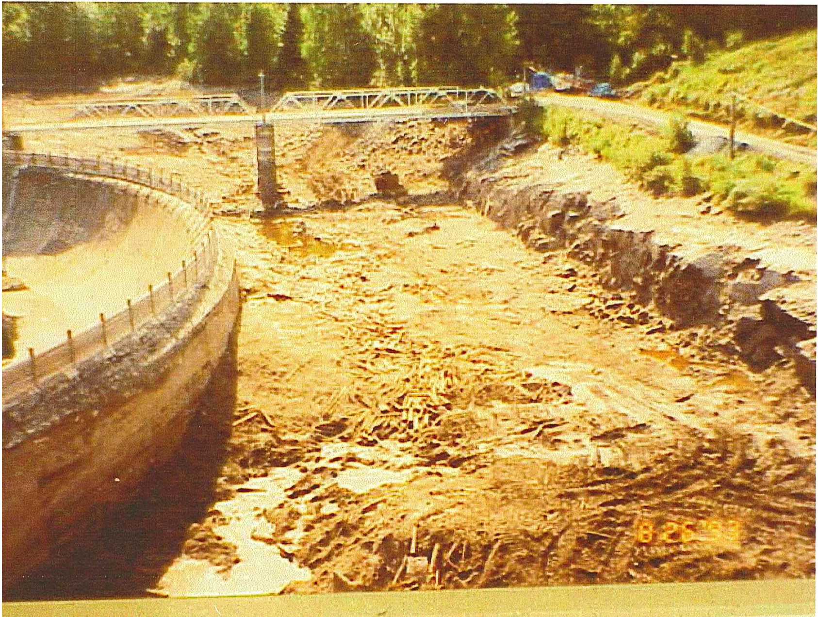
Vue du barrage déversant montrant les batardeaux mobiles en bois et le bassin d'admission asséché (1993)
