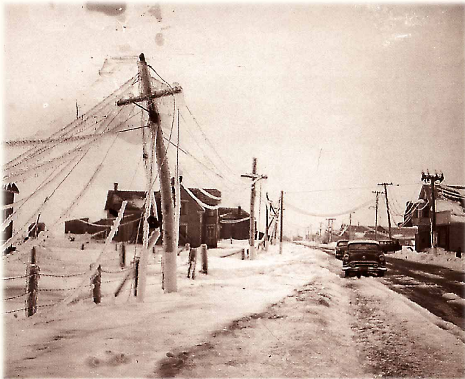
Dégâts causés par le verglas
