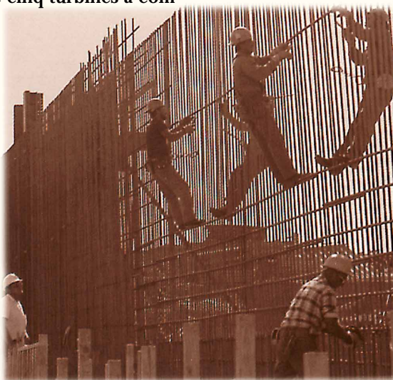
Construction de la centrale de Belledune, 1990
