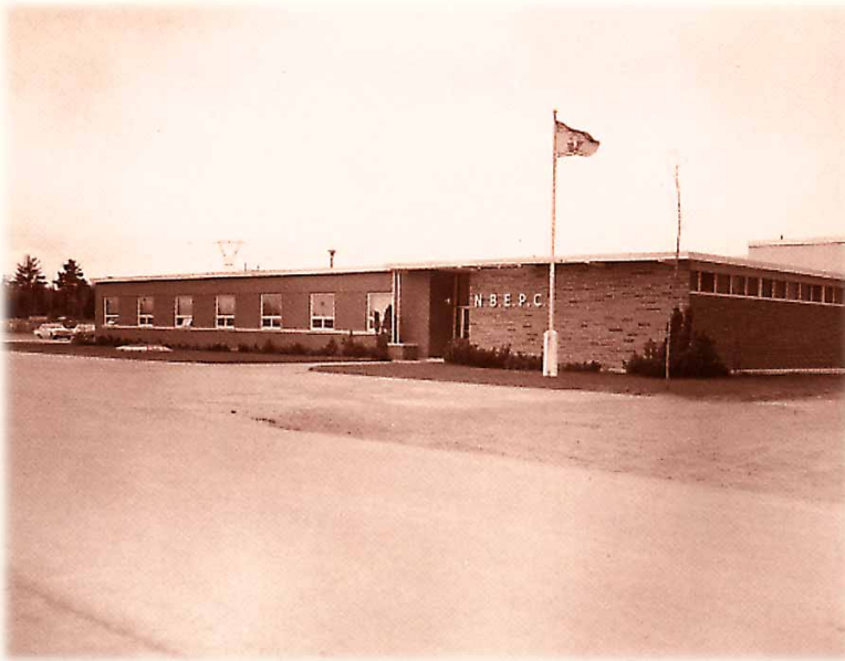
Le centre des services de Marysville, inauguré en 1968. L'expansion continue des stocks exigeait des locaux plus spacieux. La section magasins du centre des services a été détruite par un incendie en octobre 1981 et reconstruite au cours de l'été 1983
