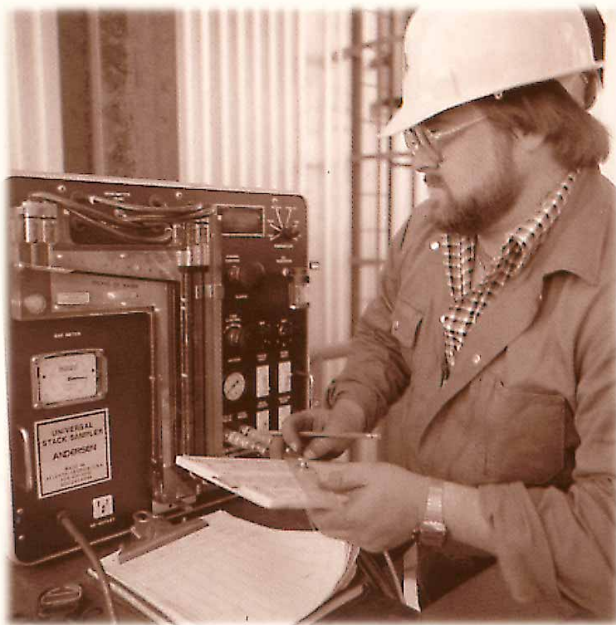
Frank Brittain, des Services techniques centraux, en train de mesurer le taux d'émissions dans la cheminée de la centrale de Chatham
