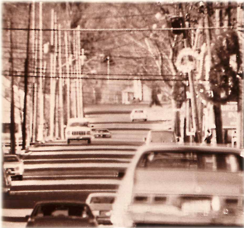
La rue Water à St. Andrews avant et après la pose du câblage souterrain. Photos de Charles Mason, St Andrews (N-B.)
