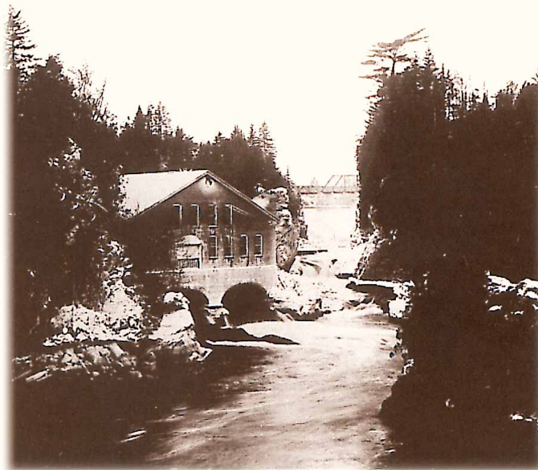
Usine électrique d'une compagnie de pâte à papier à St. George, vers 1905 (Archives nationales du Canada, PA41747)
