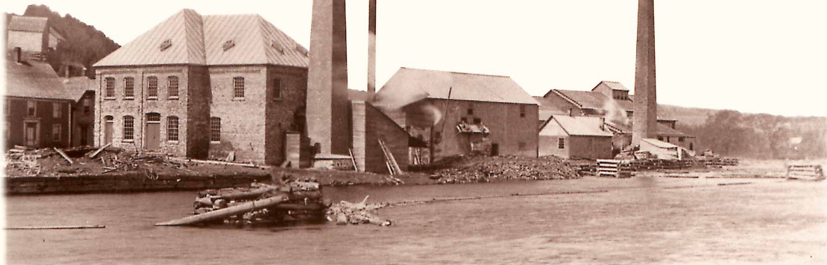
La centrale thermique de Connell Bros. à Woodstock en 1905
