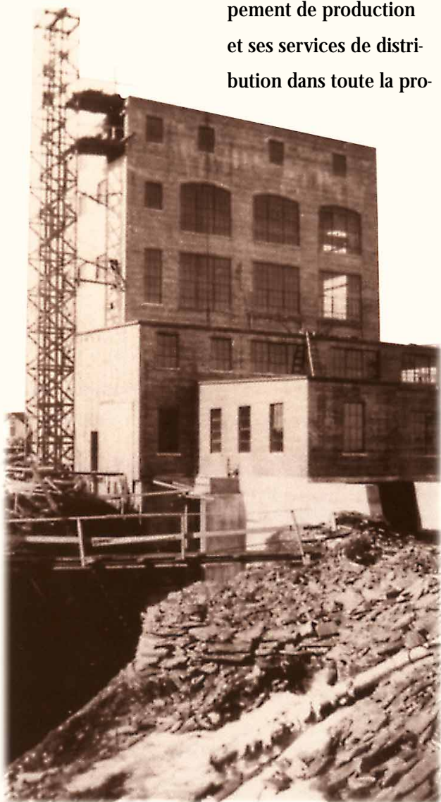
La centrale à vapeur de grand Lac en construction, 1931
