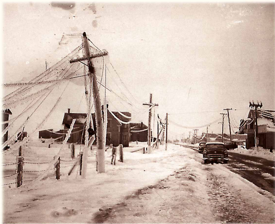
Dégâts causés par le verglas
