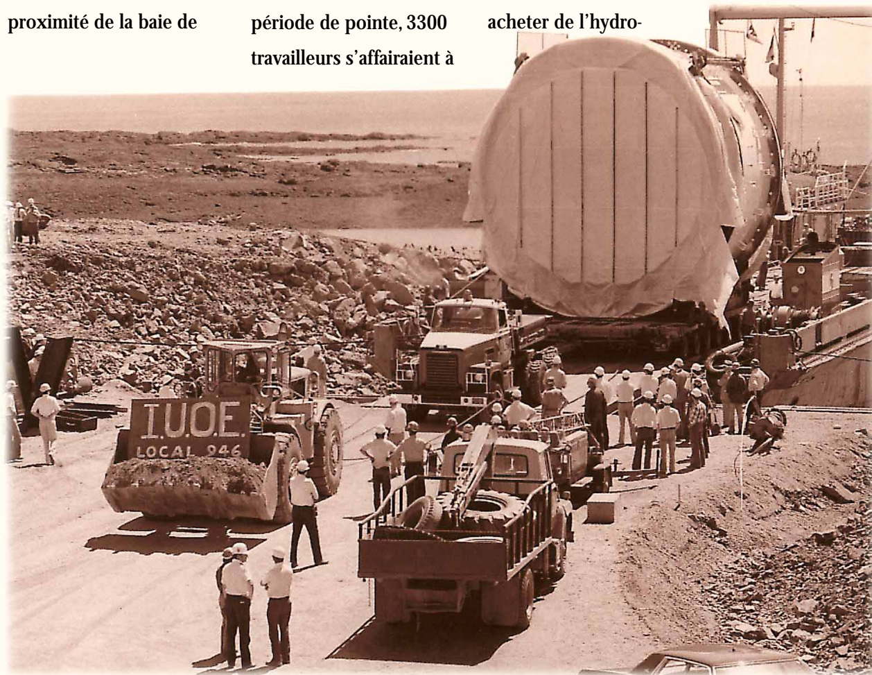
Arrivée de la calandre de la centrale de Point Lepreau, 1977
