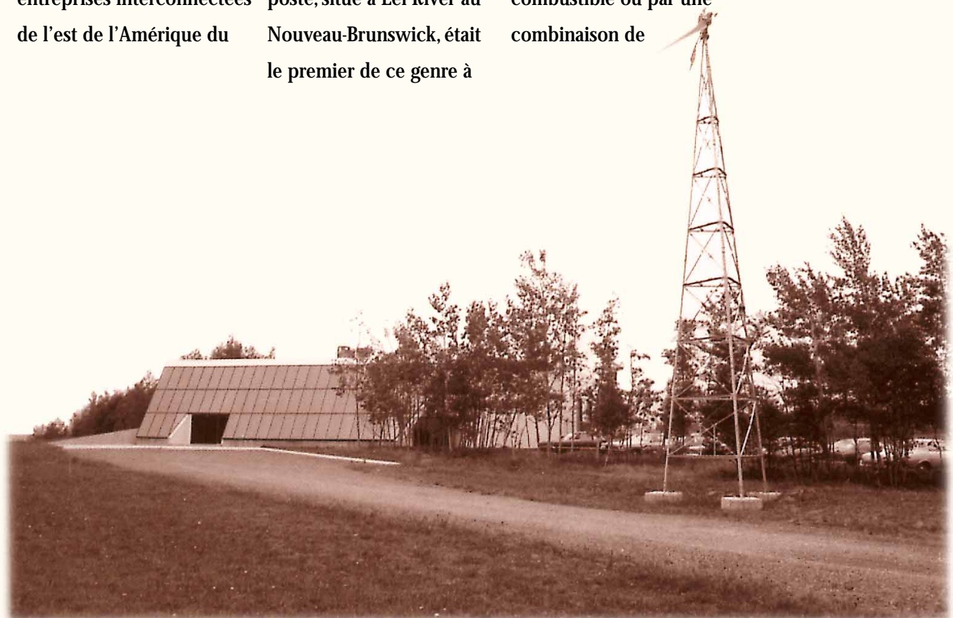
Capteurs d'énergie solaire et génératrice éolienne à Shédiac
